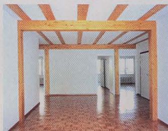
■ Les appartements traversant ne sont segmentés que par des cloisons. (Doc. Claudio Merlini.)
